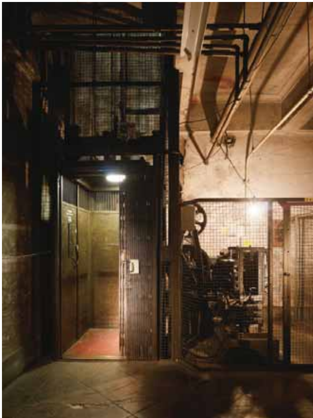
■ 図7：エレベーターを地下で撮影。蛇腹型の扉。右側に駆動装置。
