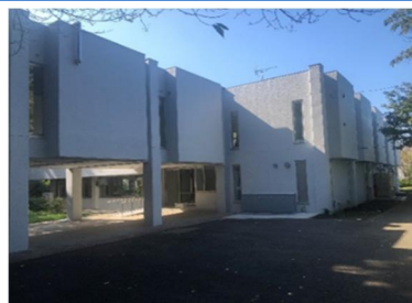
宿泊棟（令和6年11月改修完了）
