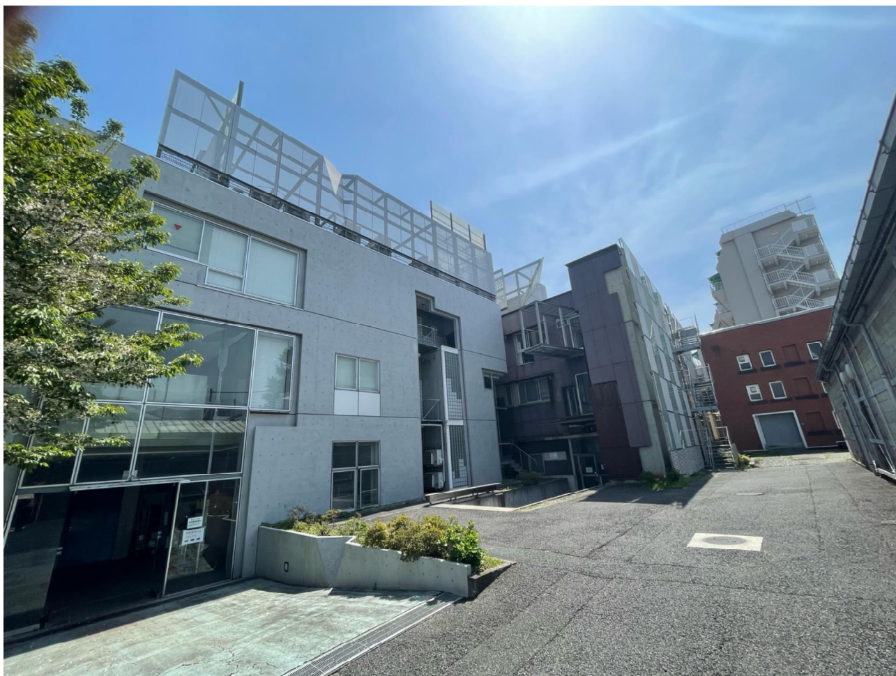
今回実験を行わせていただいた、早稲田大学 41 号館。
