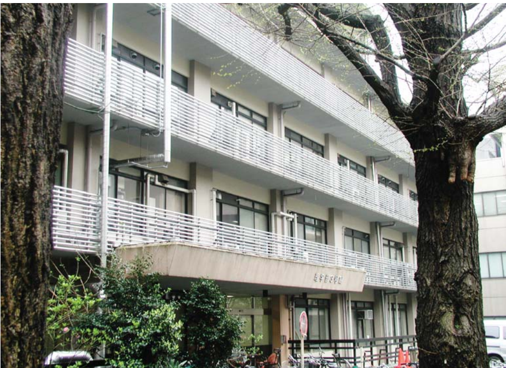
■ 図1：理学部3号館の外観
