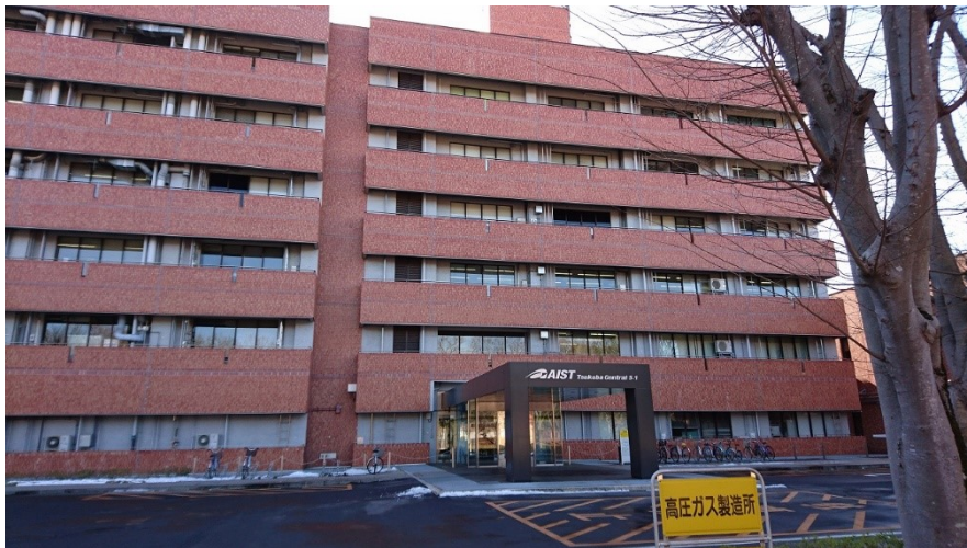
産業技術総合研究所つくばセンター第5事業所5-1棟の写真
