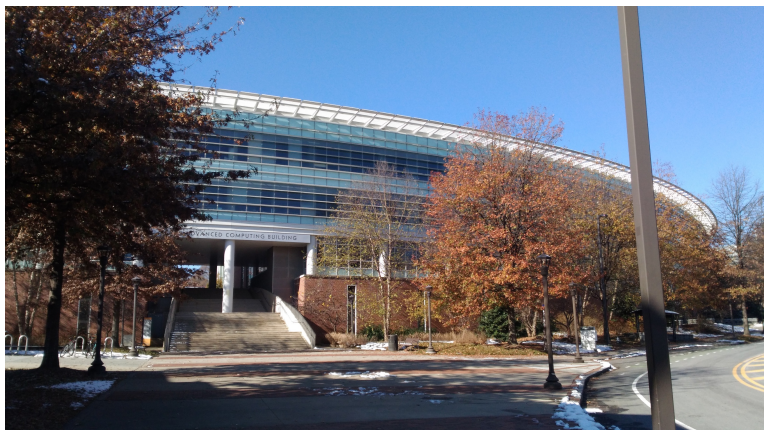
ジョージア工科大学内の Klaus Advanced Computing Building にて
